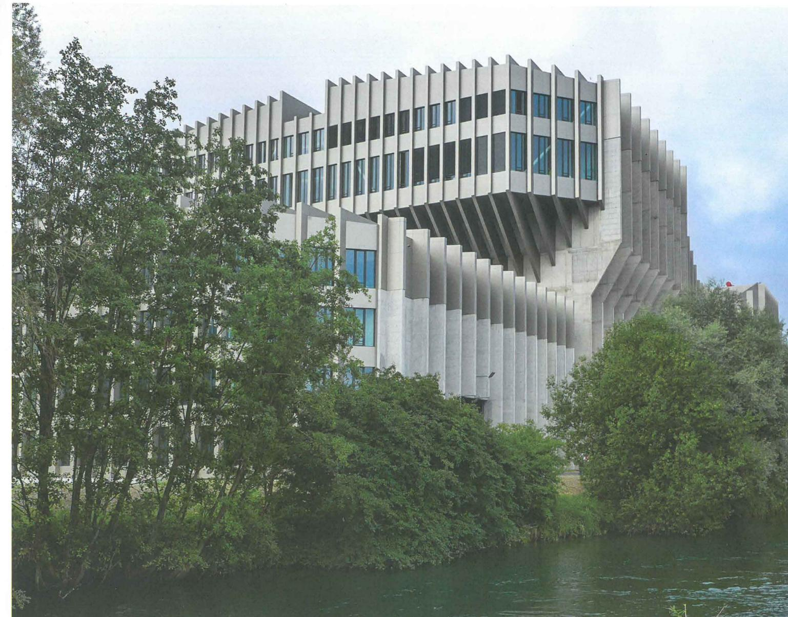
Einheit von Form und Inhalt: Die Gestalt der neuen Kehrichtverbrennungsanlage ergibt sich aus den Arbeitsabläufen im Inneren. Die plastische Rippenstruktur der selbsttragenden Fassade verleiht dem Gebäude eine bewegte Silhouette.
